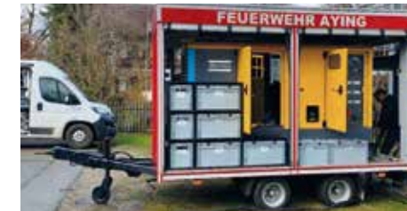
Das Notstromaggregat der Feuerwehr Aying im Einsatz am Bürgerhaus. Foto: Verwaltung
