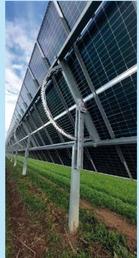
HK: Nachgeführte, schwenkbare Modultische
