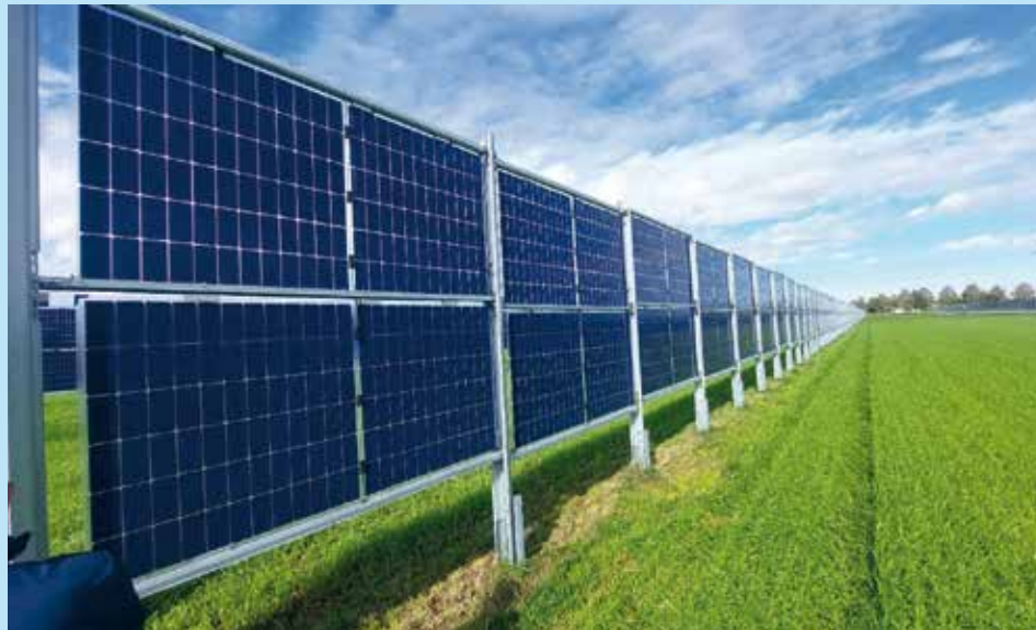
HK::Zaunsystem mit Bifacial-Modulen
