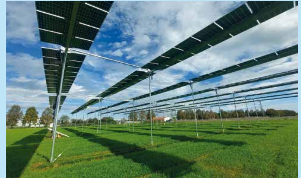
HK: hochaufgeständerte, nachgeführte Anlage
