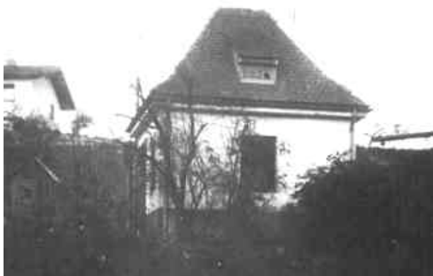
Pumpenhäusl in Peiß (Abgebrochen 1971)
